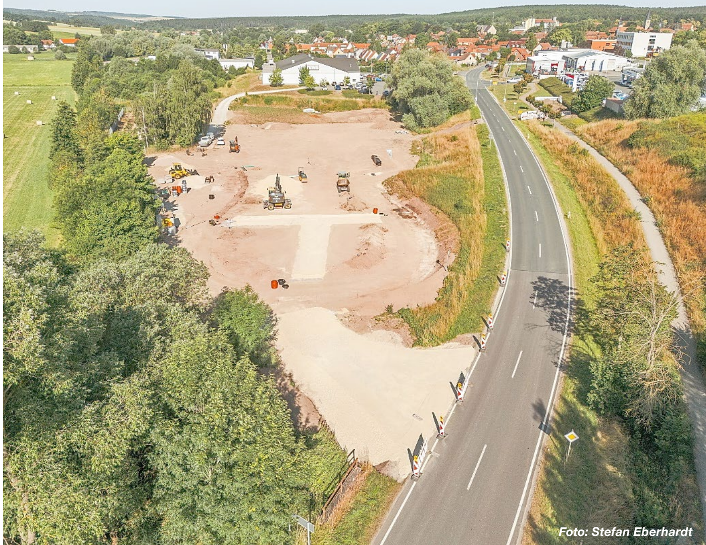
Baumaßnahme Freizeitanlage Stadt Blankenhain
